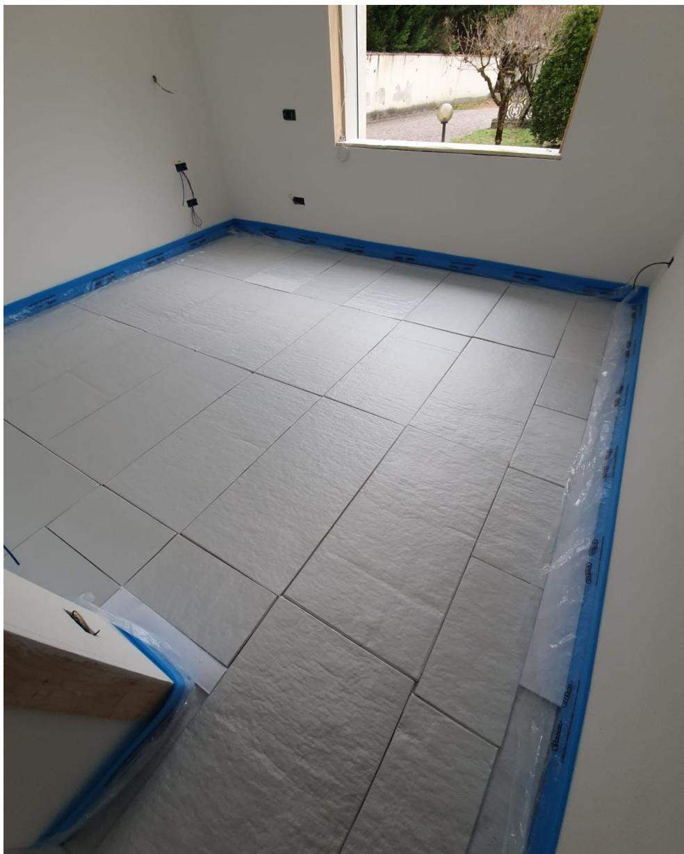
**Nota:** è' consigliato nastrare le fughe/giunti dei pannelli CZ ed il perimetro della pavimentazione utilizzando il nastro adesivo argentato ISOL-TAPE.
