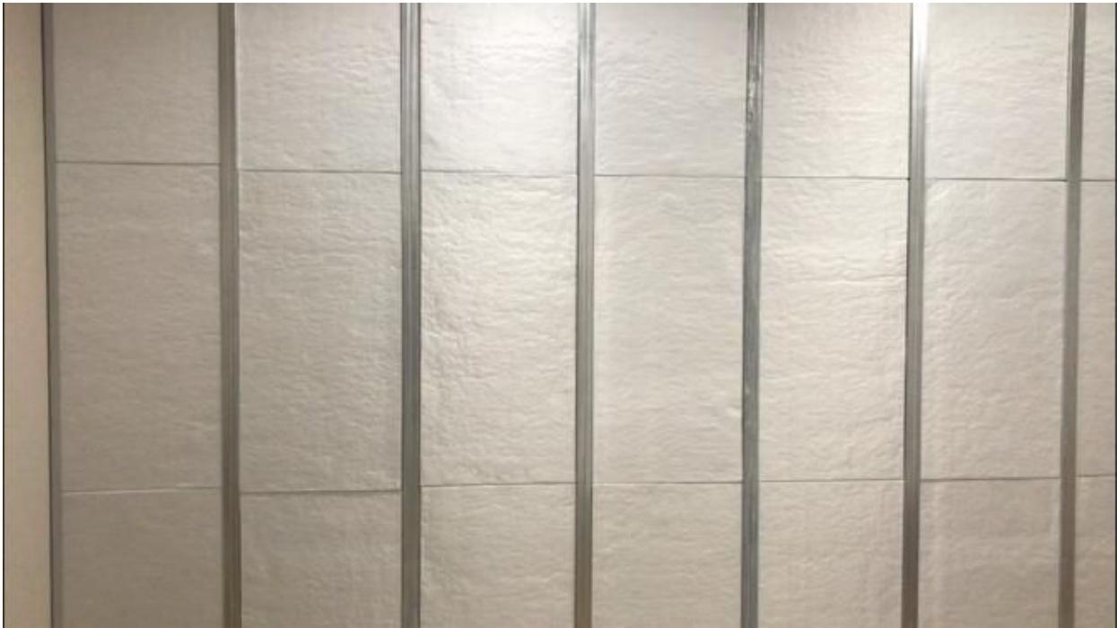
Attenzione: esercitare una leggera pressione tra pannello e pannello per eliminare le eventuali fughe/giunture. E' possibile sigillare le fughe nastrandole con il nastro adesivo argentato TAPE-CORE tipo "americano".
