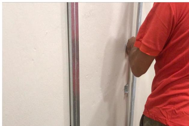
*Nota: sull'anima dei montanti sono presenti asole per il passaggio di canalizzazioni impiantistiche. Si fanno sempre corrispondere con la parte bassa della parete per agevolare il passaggio dei cavi. Se la parete è alta e si rende necessario giuntare i profili, realizzare una sovrapposizione. Pareti alte richiedono un attento dimensionamento delle orditure portanti, per il quale si rimanda alla consulenza tecnica di un Rivenditore qualificato.*
