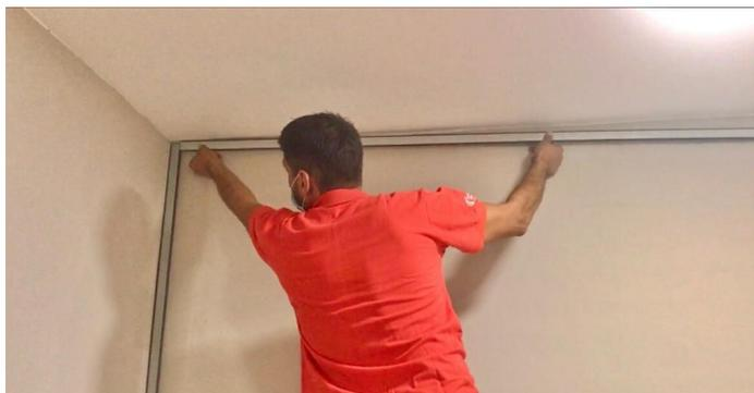
Applicare la guida superiore al soffitto, con fissaggi idonei al supporto, posti ad interasse massimo di 50 cm .
