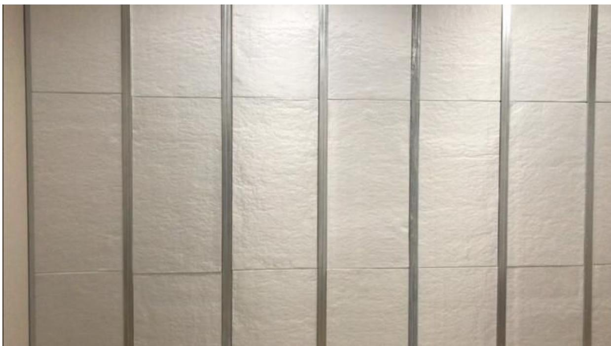
Attenzione: esercitare una leggera pressione tra pannello e pannello per eliminare le eventuali fughe. E' possibile sigillare le fughe nastrandole con il nastro adesivo argentato ISOL-TAPE tipo "americano".
