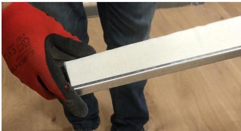
Si passa successivamente al posizionamento dei montanti. Tagliare i profili montanti a "C" della lunghezza pari alla distanza tra le guide, diminuita di 15 mm per facilitarne l'inserimento nelle guide.
