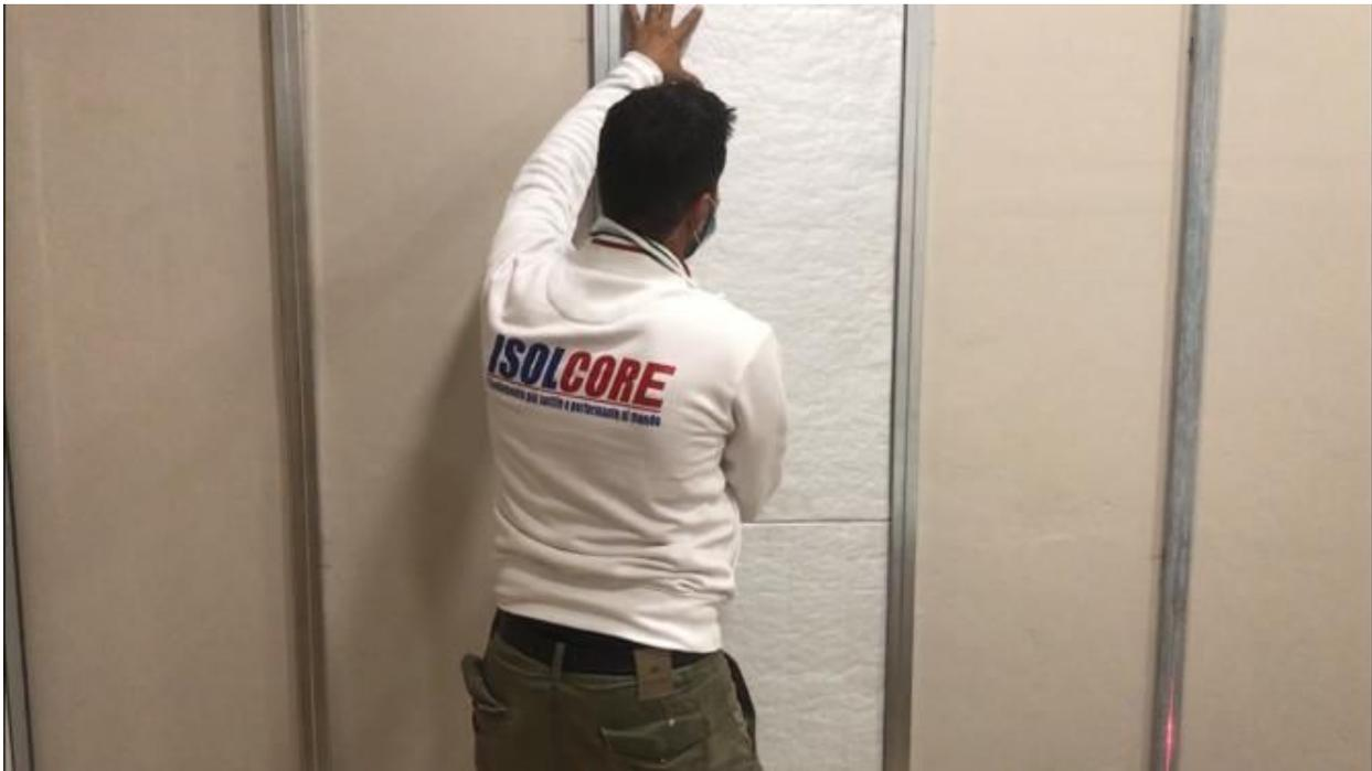
I pannelli CZ hanno diversi formati (vedi scheda tecnica), sarà cura del progettista/tecnico o del posatore verificare la misura dei pannelli per ottimizzare l'isolamento in parete o a soffitto. I pannelli CZ possono essere posati sia nel verso orizzontale che in quello verticale, in questo
