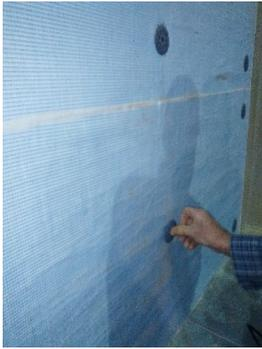
I pannelli isolanti AEROGEL-SW vengono fissati meccanicamente con i tasselli ad espansione DIPK in ragione di minimo 6/m<sup>2</sup> e con lunghezza tale da garantire il fissaggio all'interno della muratura come prescritto dal costruttore e comunque fino a raggiungere uno strato meccanicamente idoneo. Il numero minimo di tasselli viene incrementato in corrispondenza degli angoli ed in funzione dell'altezza dell'edificio e della sua collocazione geografica.
